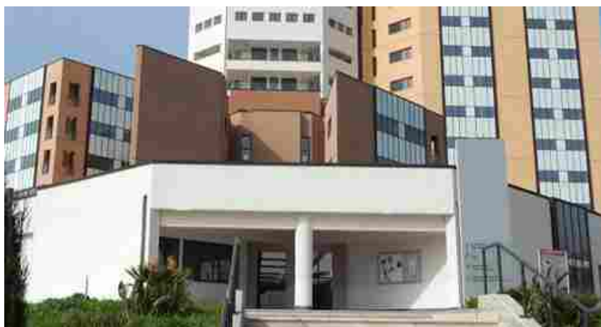
Torre Biologica a Catania
